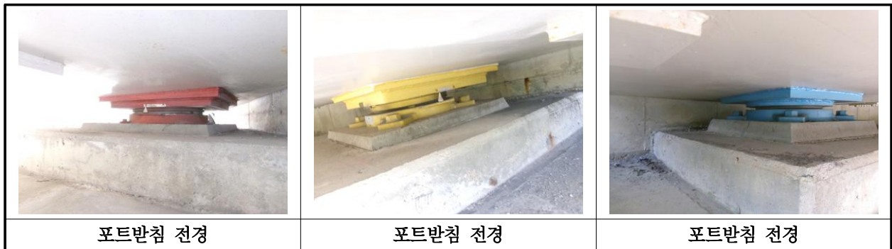
【사진 15.3.10】 교량받침 전경
