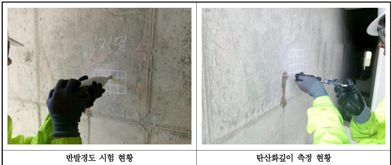
【사진 15.4.1】 콘크리트 내구성조사 현황
