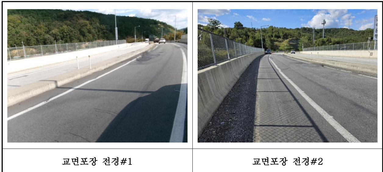
【사진 15.3.17】 교면포장 전경
