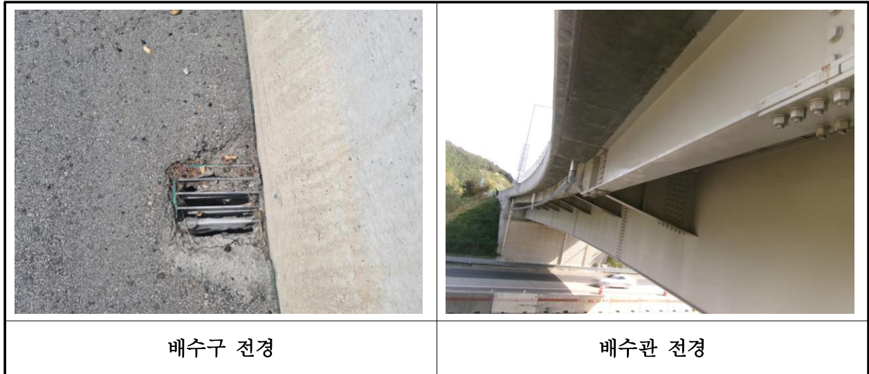
【사진 15.3.19】 배수시설 전경
